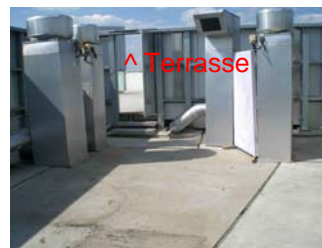
F_OG8_005 Blick nach Norden
