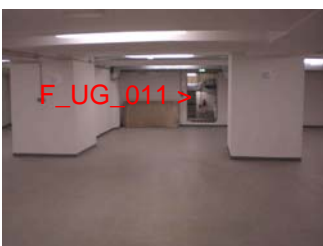
F_UG_020 Tür Richtung Lüftungszentrale (F_UG_011)
