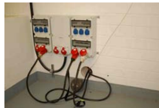
Kabeldurchbruch in C_UG_004
