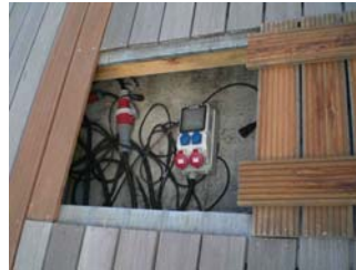
ÜP3 unter der Holzbeplankung
