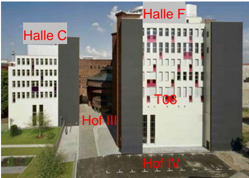
Blick nach Osten auf Hof IV und Hof III
