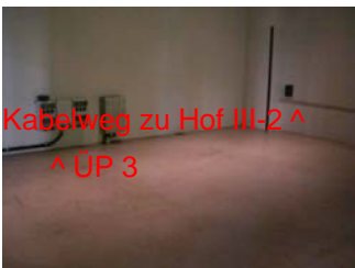
Blick nach Südost
