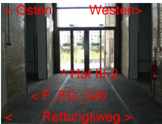
F_EG_019 Blick nach Süden aus Halle F zu Hof III-2
